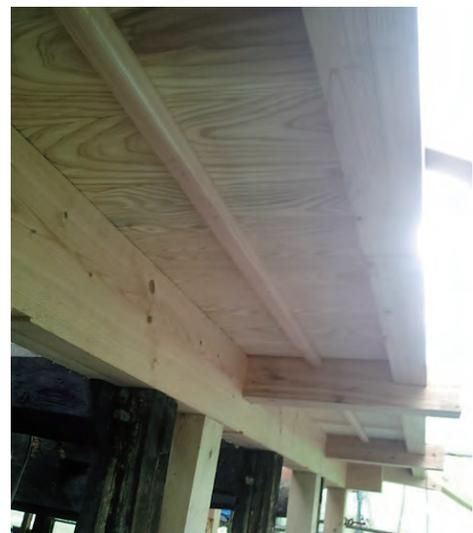
腐食した部分の船外造りの改修(復元)
