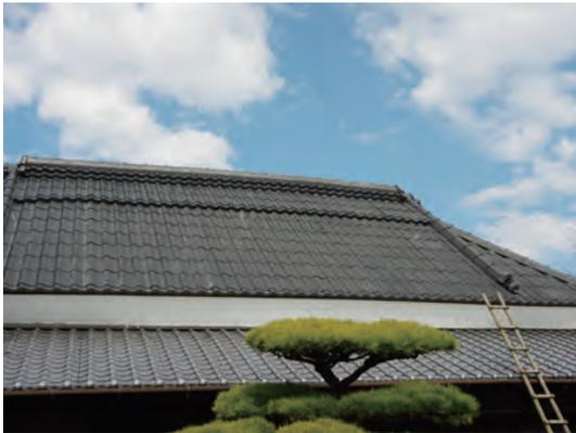
主屋屋根 上段はスレート葺きで下野は瓦葺き
