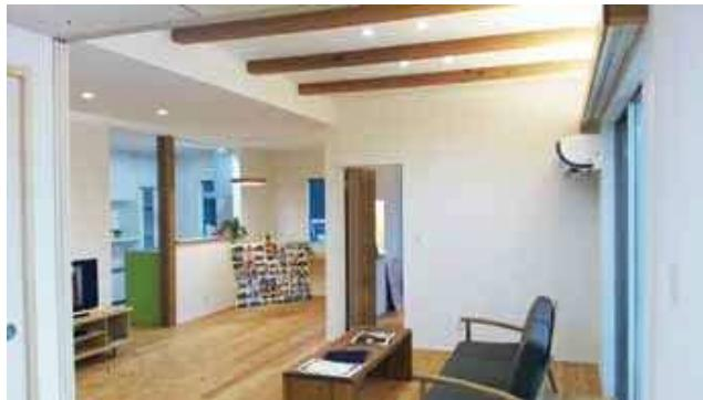
床素材はパイン無垢板に自然塗装を施し、壁天井は漆喰塗り、一部木製梁を露出させ自然な風合いをもたせた。
