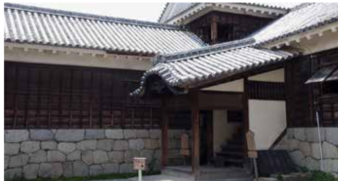
▲写真⑧ 玄関（唐破風）と北隅櫓、十間廊下（左）玄関多間櫓
