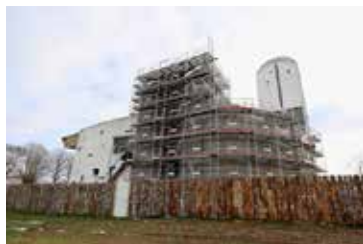
▲ 改修中の北面
