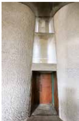
▲ 北面出入口内部
