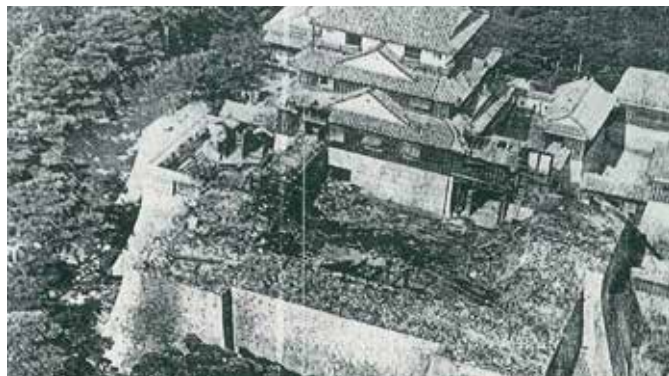
▲写真② 放火により本壇の西半分を焼失（松山市提供）
