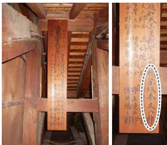
▲ 神の湯本館小屋裏の棟札 ▲
