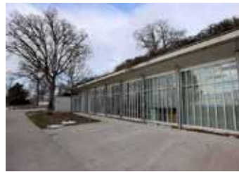
▲サンクレア修道院
