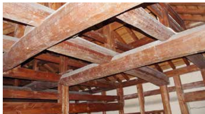
▲写真③ 筒井門続櫓（復元）の小屋組の様子
