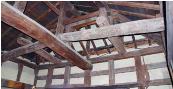
▲写真⑤ 乾櫓（江戸期）の小屋組の様子
