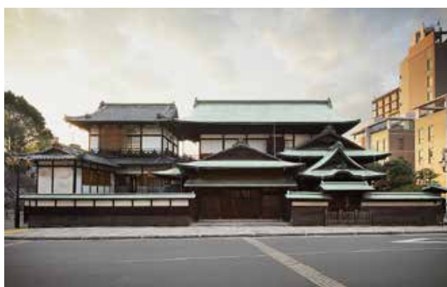
▲ 保存修理工事前の道後温泉本館（又新殿・霊の湯棟）
