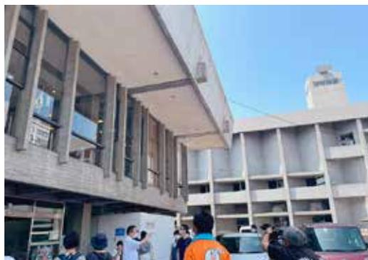
公会堂では、1400席を確保する大スパンを実現させた屋根・壁の折板構造を見学しました。普段経験できない舞台上にも上がらせていただき、舞台袖の目に触れないところでは、仕上げられていない打放しのままの折板構造の壁を確認することもできました。
