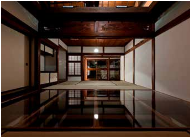
▲ 2階客間 床面は畳を撤去し強化硝子敷 創建時の天井を撤去、小屋組を表している
