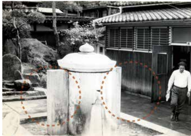
▲昭和30～40年頃の飲泉塔。点線部に「控え柱」が見える（山鹿市観光課提供、著者加工）
